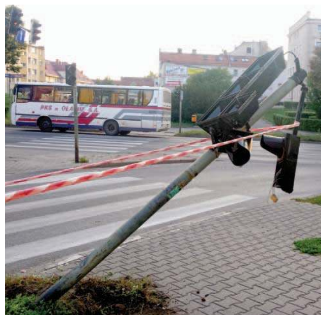
Sygnalizator świetlny został poważnie uszkodzony
