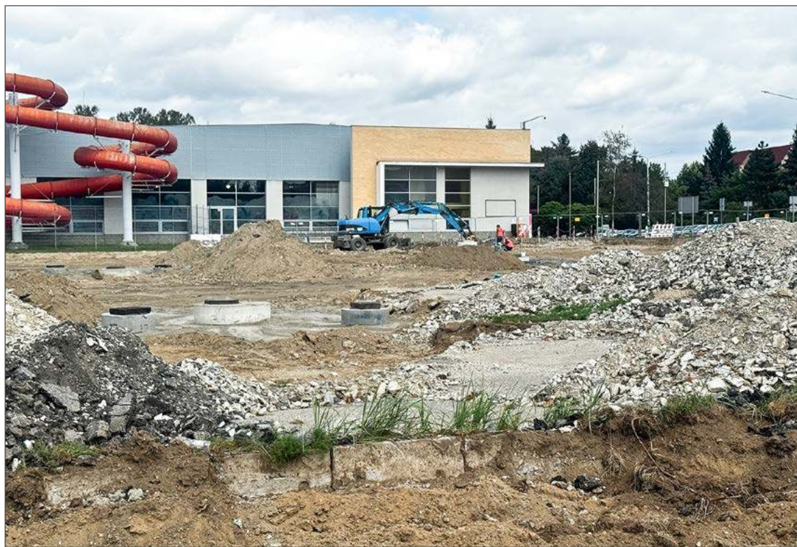
Parking pod stadionem i halą basenów i lodowiska to na razie plac budowy.
