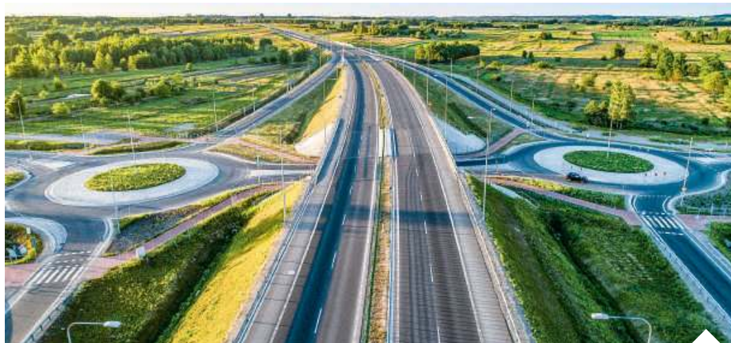
W Polsce budowa Via Carpatii postępuje niezwykle dynamicznie. Niedawno do użytku został oddany cały ciąg drogi między Lublinem a Rzeszowem | fot. GDDKiA/d
