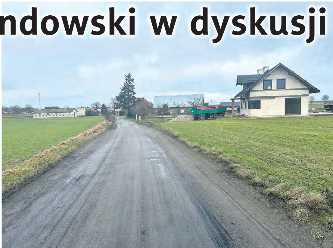
Ulica Wodna w części jest teraz drogą gruntową. Według planów gminy ma tam być asfalt.
