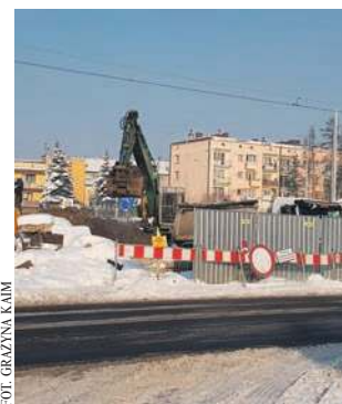
Roboty przy wiadukcie na 29 Listopada w Chrzanowie
