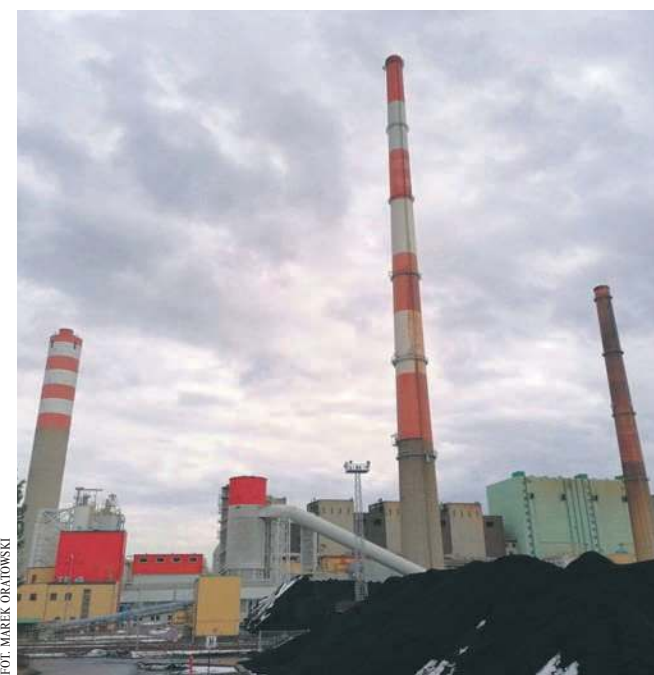
Komin z Sierszy to 31. pod względem wysokości konstrukcja w Polsce
