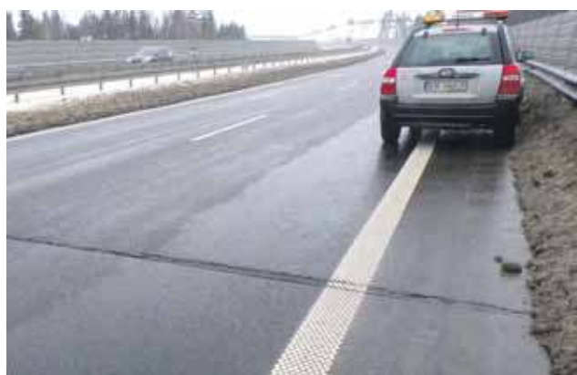
Pęknięcia w asfalcie pojawiły się ledwo rok po otwarciu nowego odcinka drogi krajowej.
