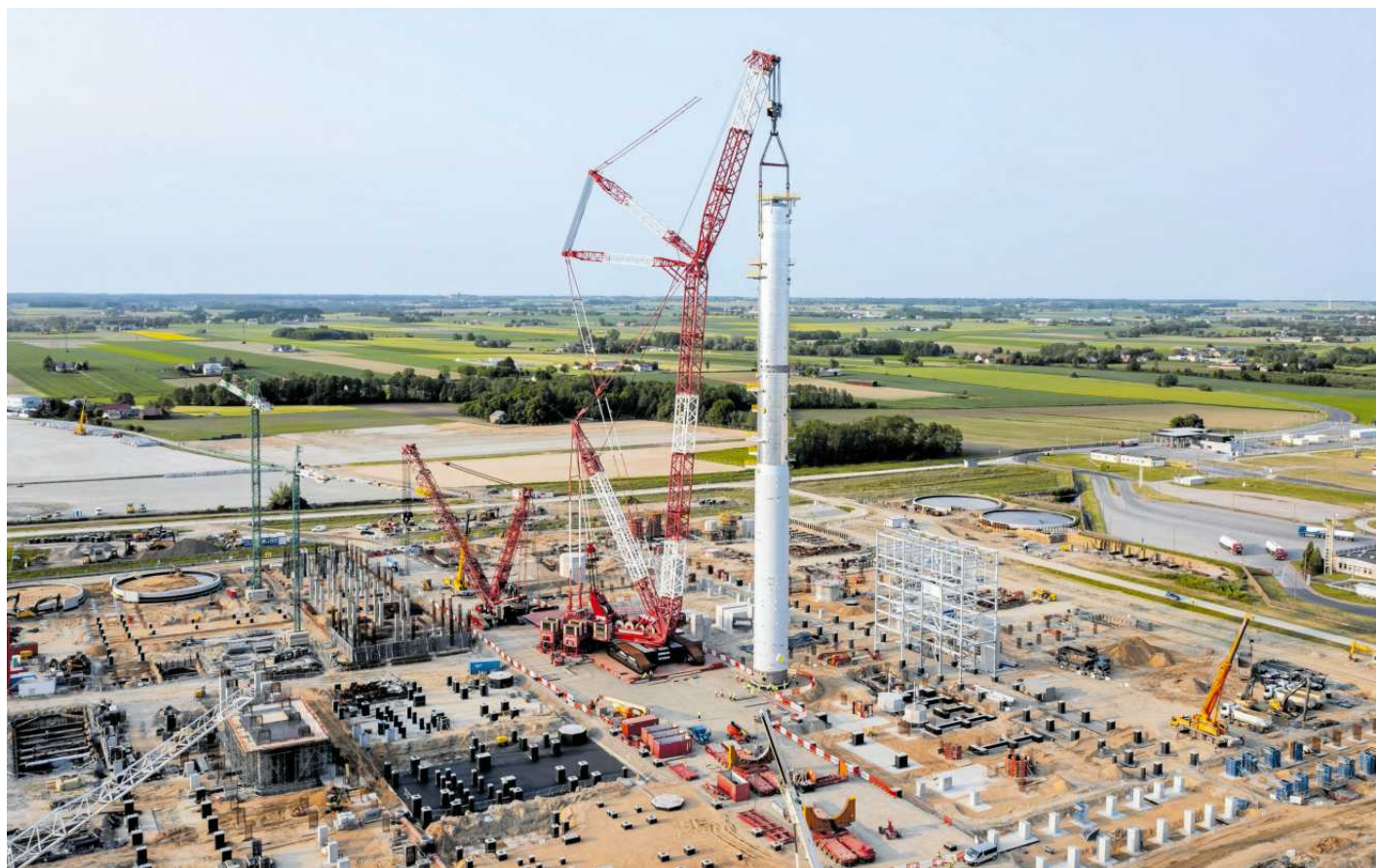
• Wash tower to największy element instalacji kompleksu Olefina III FOT. MATERIAŁY PRASOWE ORLEN
