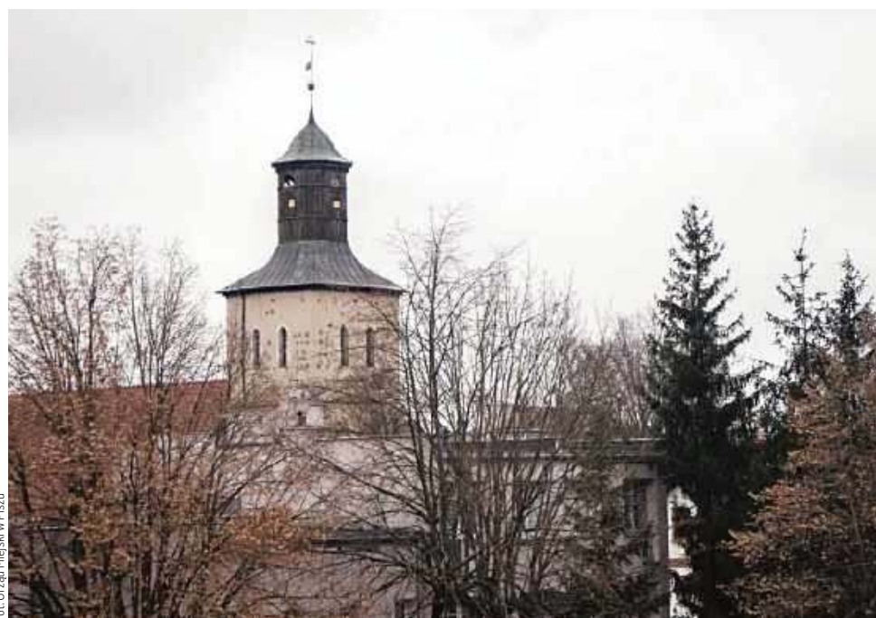
Zegar zniknął, przechodzi gruntowną renowację
