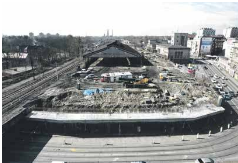
Prace przy przebudowie wiaduktu wchodzą w nową fazę
