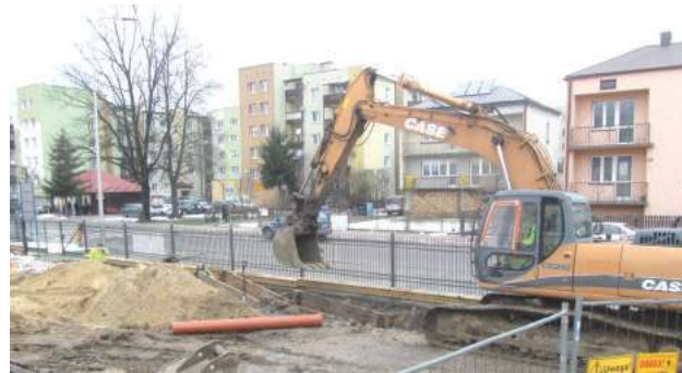
Plac budowy przy Zespole Szkół Budowlanych
