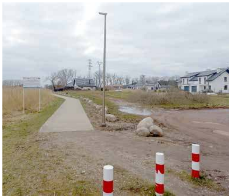
Pierwsza z zamontowanych lamp na początku roku widoczna od strony ul. Promenady
