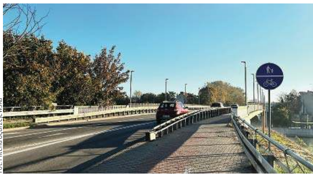
O tym, że most Kardynała Wyszyńskiego potrzebuje pilnego remontu, mówiło się już pod koniec 2021 roku
