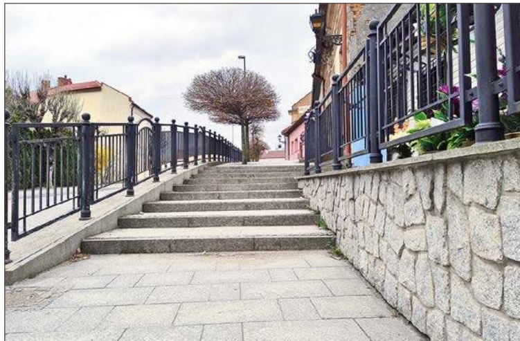
Tych schodów osoba na wózku inwalidzkim nie jest w stanie pokonać.
