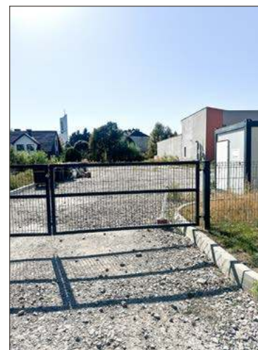
Na razie parking na Ogrodowej to jeszcze cały czas plac budowy.
