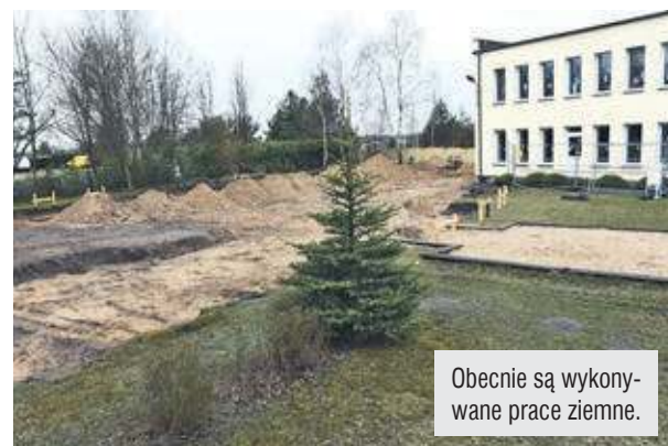
Z działki przed przedszkolem wycięto już zieleń. To przygotowanie miejsca pod nową drogę dojazdową.
