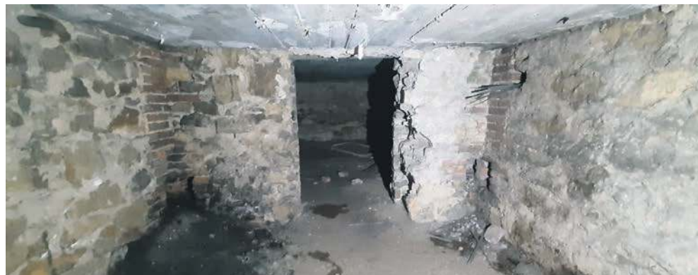
Piwnica i stare fundamenty budynku
