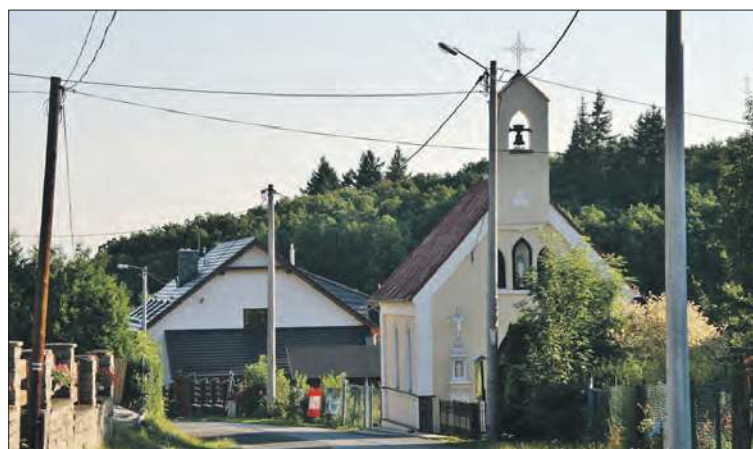
Samorząd chce zmodernizować jedną z dróg w Dębowiecu
