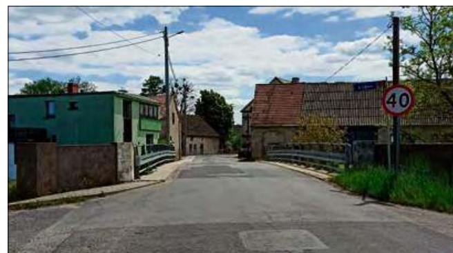
Prace na drogach powiatowych obejmowały m.in. most w Strzeleczyńskich.
