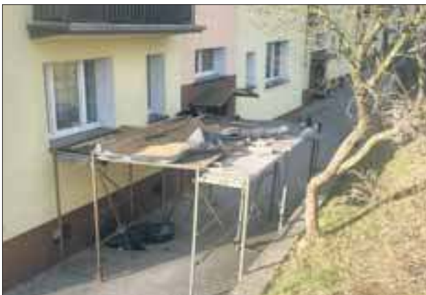
Konstrukcję zbudowano celem ochrony przed spadającym śniegiem
