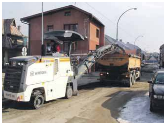
Drogowcy zdzierają asfalt na Długiej.
