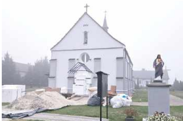
Trwają już prace przy zabytkowym kościele pod wezwaniem Niepokalanego Poczęcia NMP w Kozuszkach
