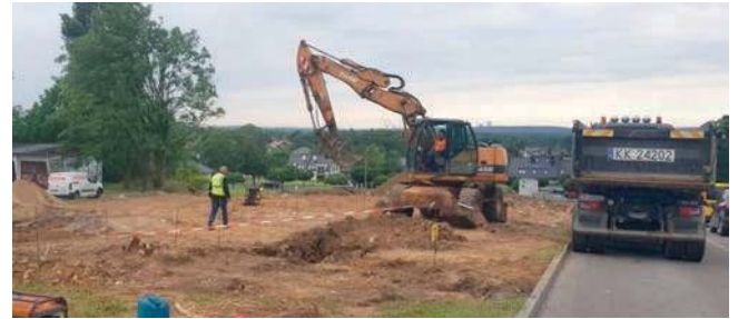
Z budowanego parkingu skorzystają w przyszłości m.in. klienci krytej pływalni
