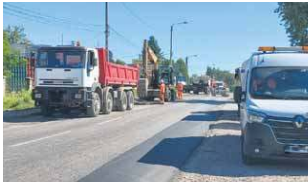
Trwający remont kanalizacji powoli dobiega końca
