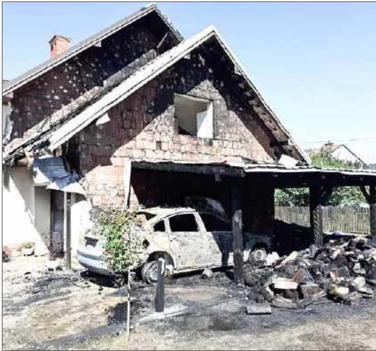
Zniszczeniu uległ samochód, wiatą i dach nad garażem Fot. KP PSP.
