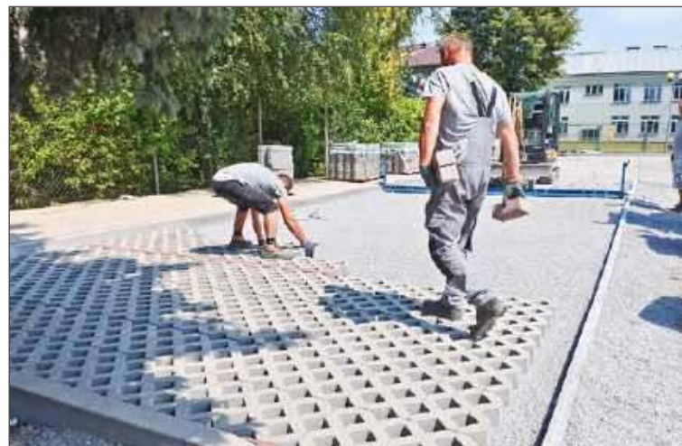
Po zakończeniu prac będzie tu miejsce na 29 samochodów.
