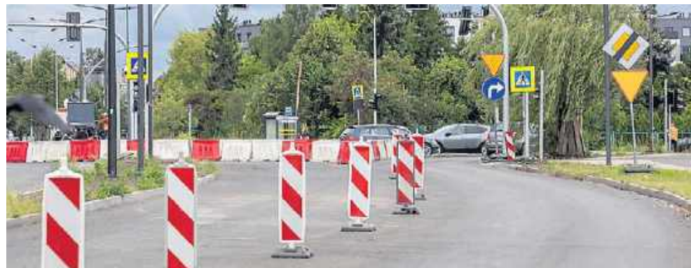
To już naprawdę ostatnia prosta. W poniedziałek na skrzyżowanie Kamiennej i Sułkowskiego powróci stała organizacja ruchu.
