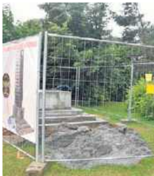
Zakończono już pierwszy etap prac i wmurowano kamień węgielny
