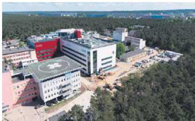
Trwająca rozbudowa Wojewódzkiego Szpitala Specjalistycznego we Włocławku FOT. MIKOŁAJ KURAS DLA UMWKP
