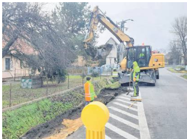
W Rakowicach trwa budowa chodnika na tzw. elkach, które stanowią będą konstrukcję, ponieważ powstanie on obok głębokiego rowu. Fot. Tomasz Gracz
