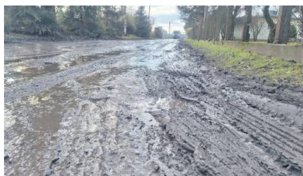
Ulica Kolejowa w Wiązowie jest cała zablokowana
