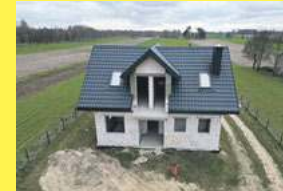
Dom w stanie surowym otwartym, Wólka Siemieńska, 885 851 160
