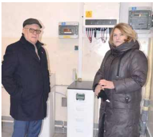
Zakres zadania obejmował przebudowę źródła ciepła pracującego dla potrzeb starostwa, szkoły ZSZ nr 2 w Rykach oraz budynku warsztatów szkolnych
