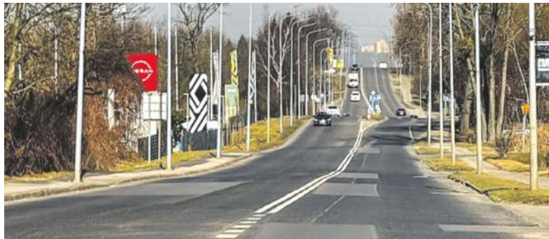
Naprawa uszkodzonej jezdni ucieszy kierowców
