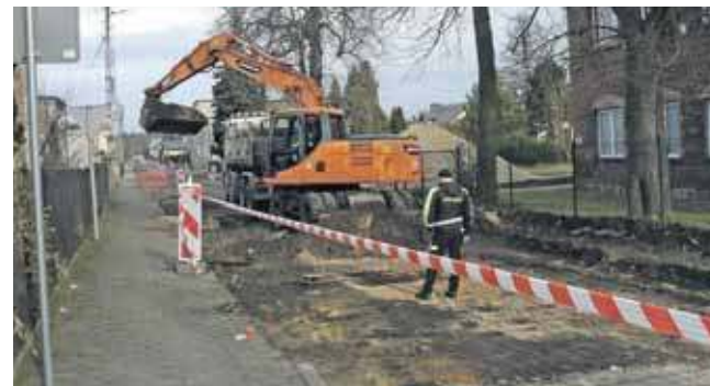
Trwa remont ul. Plebiscytowej w Świerkłańcu. Jednak nie cała zyska nową nawierzchnię
