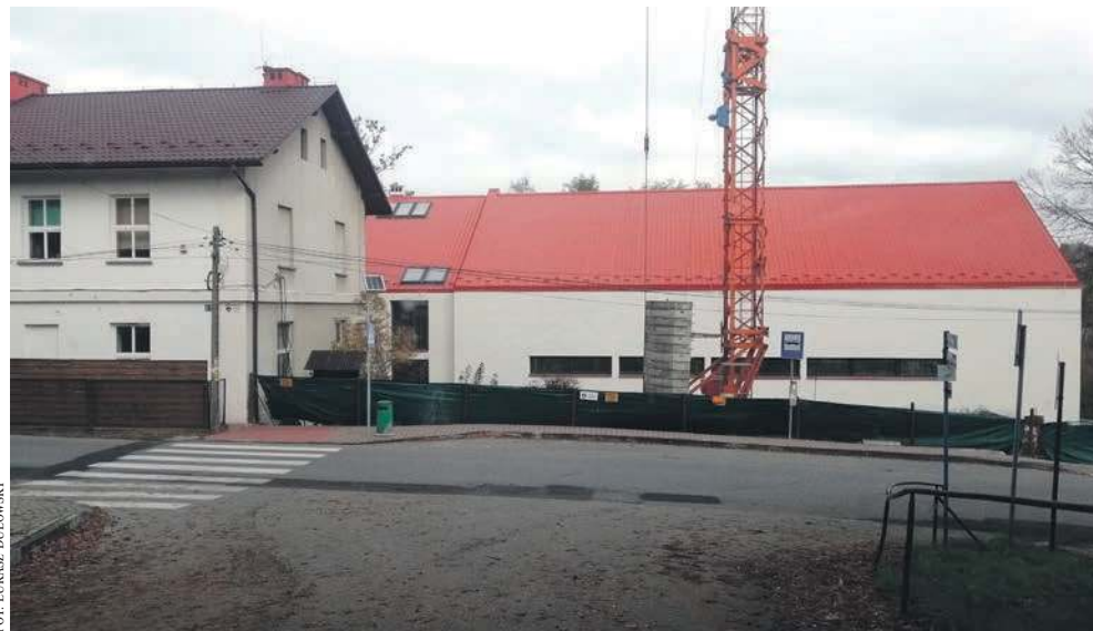
Trwa rozbudowa Szkoły Podstawowej w Grojcu
