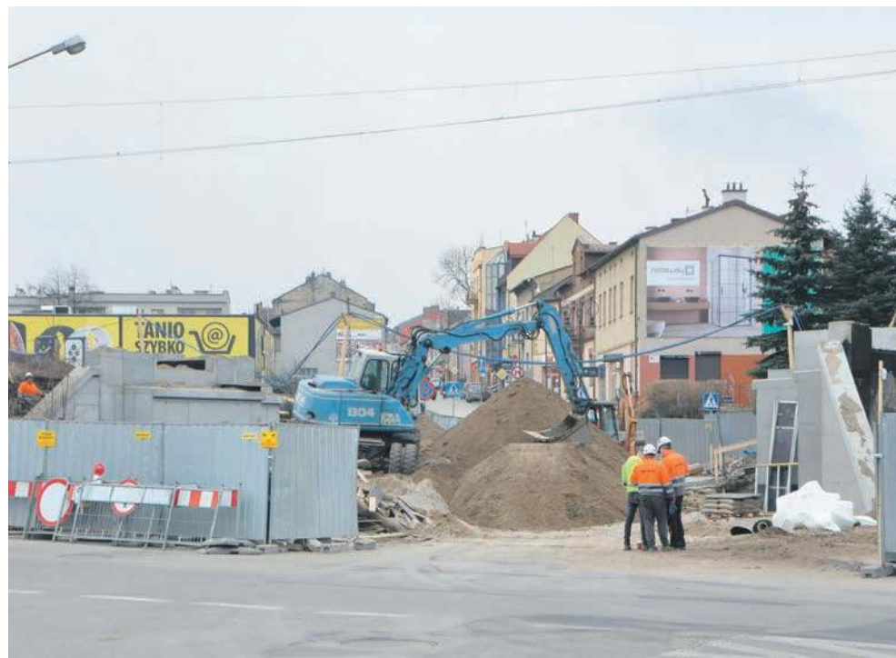
Widok na przebudowywany wiadukt nad ul. Krakowską
