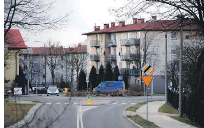
Jedną z ostatnich inwestycji realizowanych przez chrzanowski TBS był blok przy Szarych Szeregów 21 na osiedlu Południe. Widok od strony ronda na Pogorskiej
