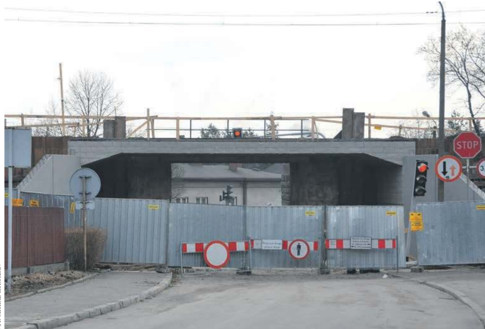
Wiadukt nad ul. Kadłubek
