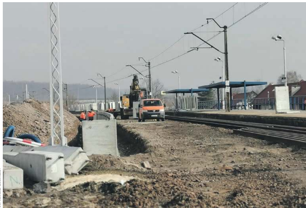
Prace w rejonie stacji kolejowej Chrzanów Śródmieście
