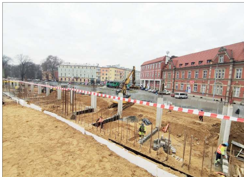
■ W maju 2023 roku ma być gotowa główna część budynku nowego dworca
