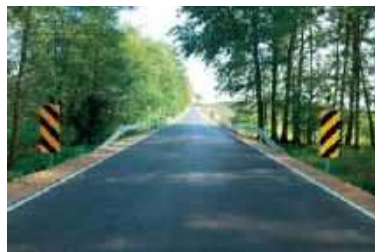
Po przebudowie droga powiatowa w Lisowie jest bezpieczna, zapewnia kierowcom większy komfort jazdy.
