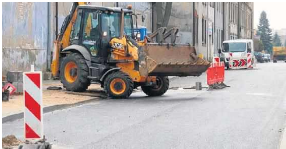
Na ulicy Dąbrowskiego, na radomskich Glinicach, zakończono już wymianę kanalizacji.
