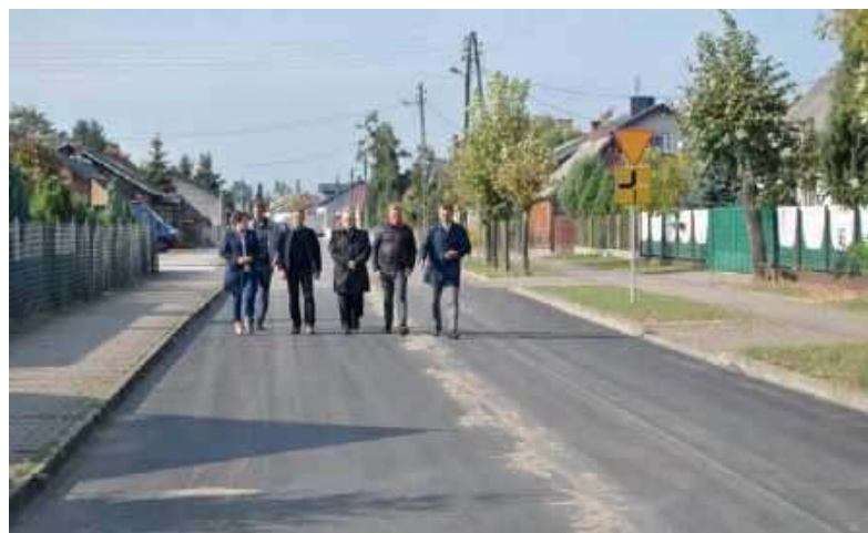
Ulica Batorego w Wyśmierzycach już została przebudowana. To odcinek drogi powiatowej i za prace płać białobrzeskie Starostwo.
