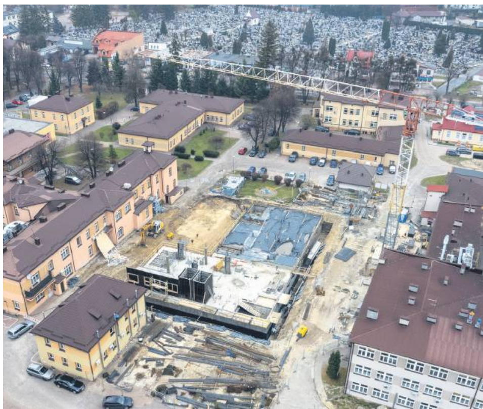
Na terenie powiatowego szpitala trwa rozbudowa.
