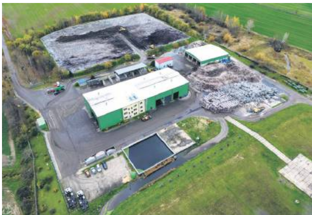
Zakład Zagospodarowania Odpadów w Łaskowie.
