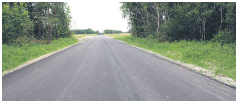
Droga w Pasiekach. Na tę wielomilionową inwestycję czekało wielu mieszkańców.
