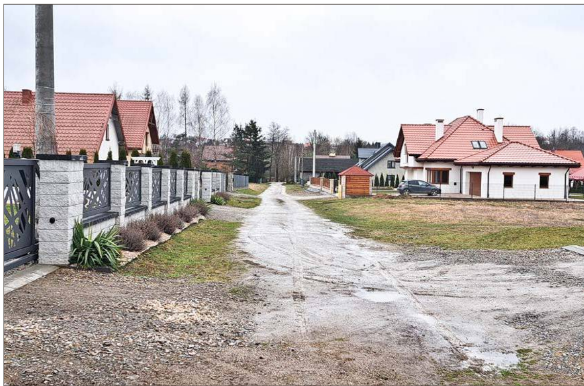
Jedną z budowanych dróg będzie ta prowadząca do domów w Nawsiu Brzostecim.
