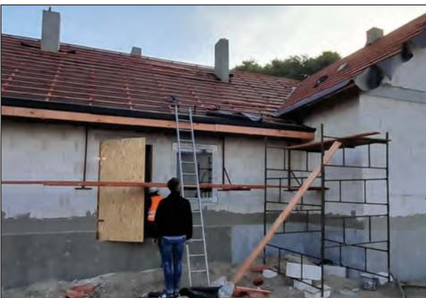
Projekt zakłada budowę na terenie oczyszczalni nowych budynków technicznych i socjalnych. Na chwilę obecną są one w stanie surowym
