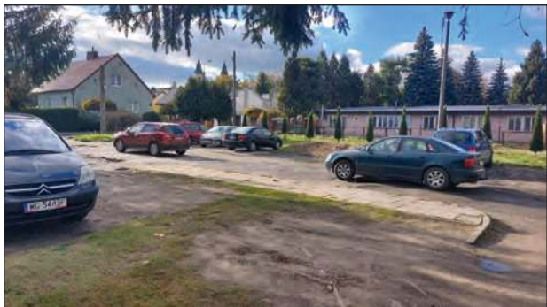
☛ Żeby jednak stworzyć tu profesjonalny parking, potrzebna jest kompleksowa przebudowa, która musi uwzględnić choćby kanalizację deszczową
