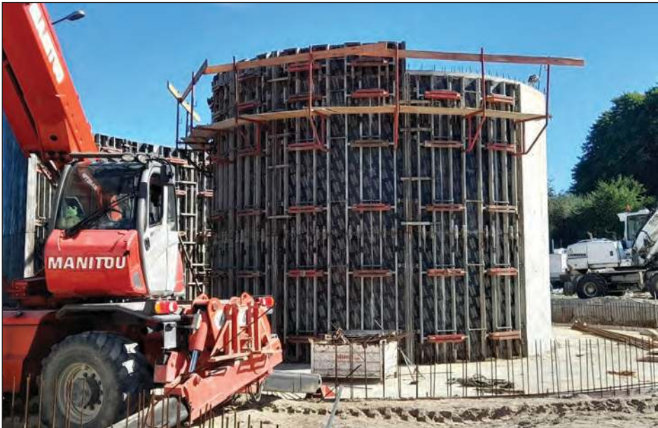
Nowa oczyszczalnia nabiera realnych kształtów. Już stoją na niej wybudowane obiekty, służące oczyszczaniu ścieków
