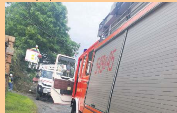
Gdy pracownicy energetyki usuwali awarię, strażacy OSP KSRG Jęglowa zabezpieczali teren. Foto: OSP KSRG Jęglowa
