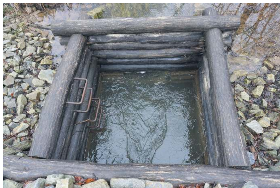
Upust dennej, który został odtworzony przez henrykowskie Nadleśnictwo w ramach realizowanego projektu. Foto: Archiwum Nadleśnictwa Henryków
