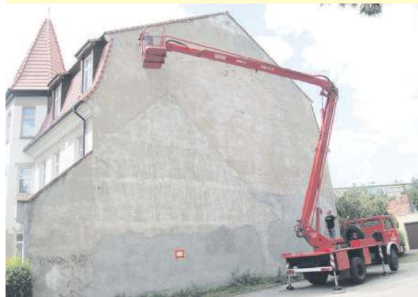
2 lipca zbadano stan techniczny elewacji budynku
