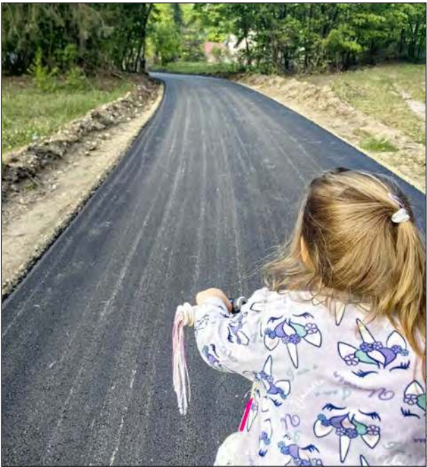
» - Udało nam się wyasfaltować pierwsze odcinki dróg. Część w zwartej zabudowie, część w terenach typowo rekreacyjnych. Ale każdy odcinek cieszy tak samo - mówi wójt Sobolewa Maciej Błachnio
