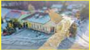
Budynek handlowo-usługowy w Misiach, 4 kilometry od obwodnicy Międzyrzecza Podlaskiego, 669 494 058
