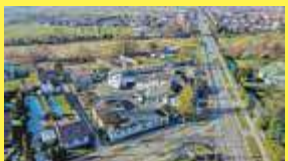
Nieruchomość przemysłowa w Międzyrzeczu Podlaskim z istniejącą hurtownią spożywczą i stacją gazu LPG. Przy ulicy Warszawskiej, blisko wyłotu na drogę E 30 (krajowa A2), 665 750 197
