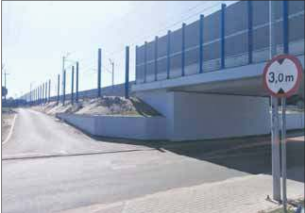
Po wielu perturbacjach, budowa wiaduktu dobiegła końca
