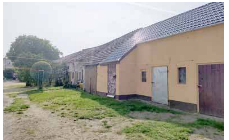
Wyremontowana została tylko część budynku. Jednak aby było bezpiecznie, konieczne trzeba zadbać także o gminną część budowli
