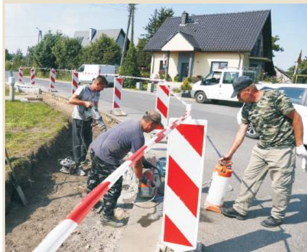
Firma PHU Waldemar Ginter pracuje nad budową nowego chodnika przy ul. Szkolnej w Przewornie
