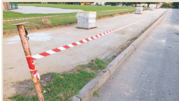
W minioną sobotę ruszyła budowa nowych miejsc parkingowych na terenie Zespołu Szkolno-Przedszkolnego w Przewornie
