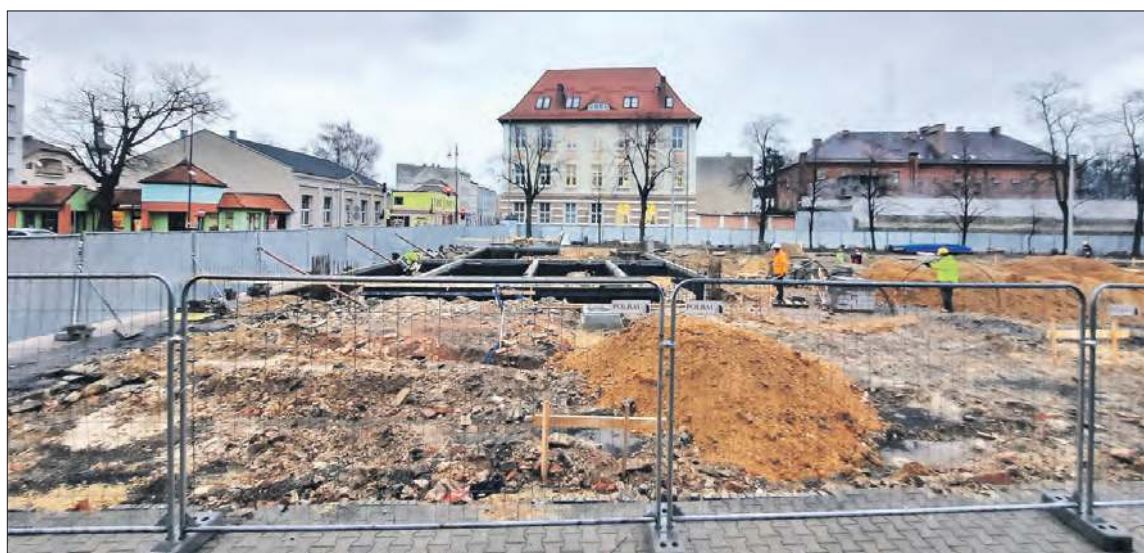
W części placu budowy od strony ul. Kościuszki widać już fundamenty budynku dworca z poczekalnią
