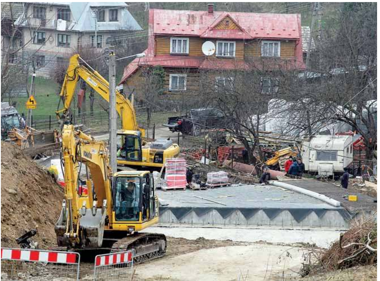
Nowy most w Rdzawce już prawie gotowy.
