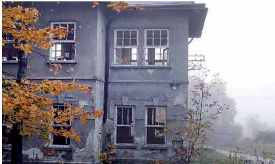
Jeden z budynków, który czeka rozbiórka.
