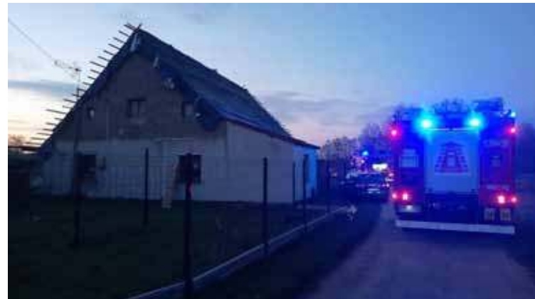
W miniony wtorek w miejscowości Płatkowo zapalił się strop w domu jednorodzinnym. Foto. OSP Chociwel
