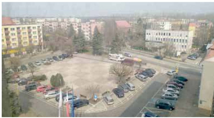
Na wykonanie widocznej części Placu Wolności brakuje obecnie prawie 4 mln zł
