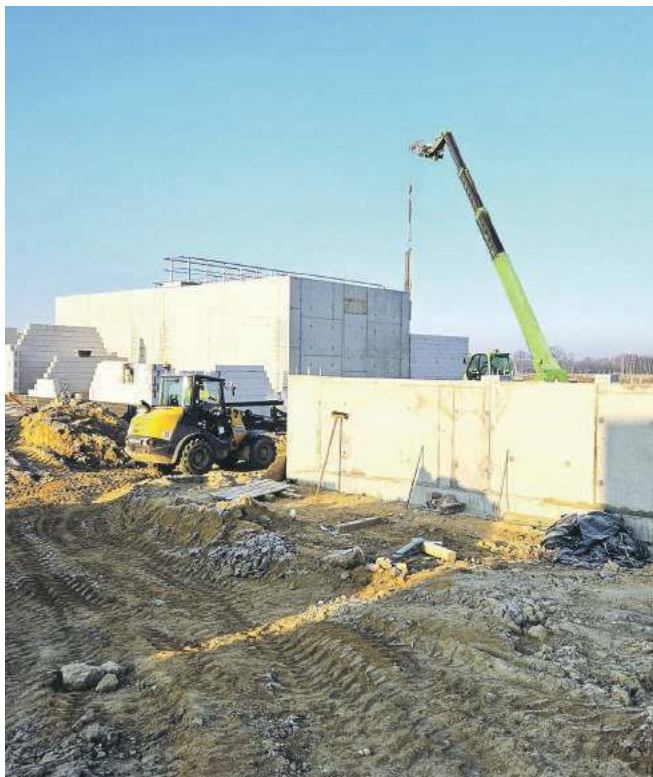
Oczyszczalnia ścieków - prace postępują
