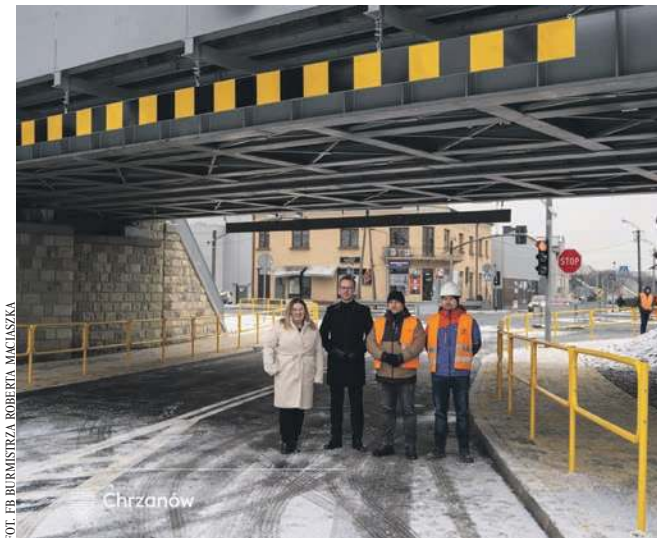
Burmistrz Chrzanowa Robert Maciaszek (drugi z lewej) pod otwartym ponad rok temu wiaduktem kolejowym nad Krakowską
