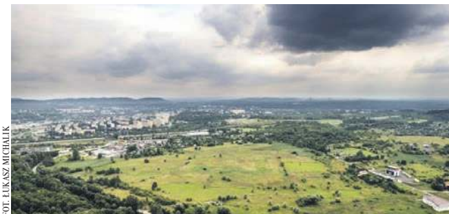
W ramach inwestycji zostanie przebudowana ul. Wodzińska w Chrzanowie i ul. Sikorskiego w Trzebini
