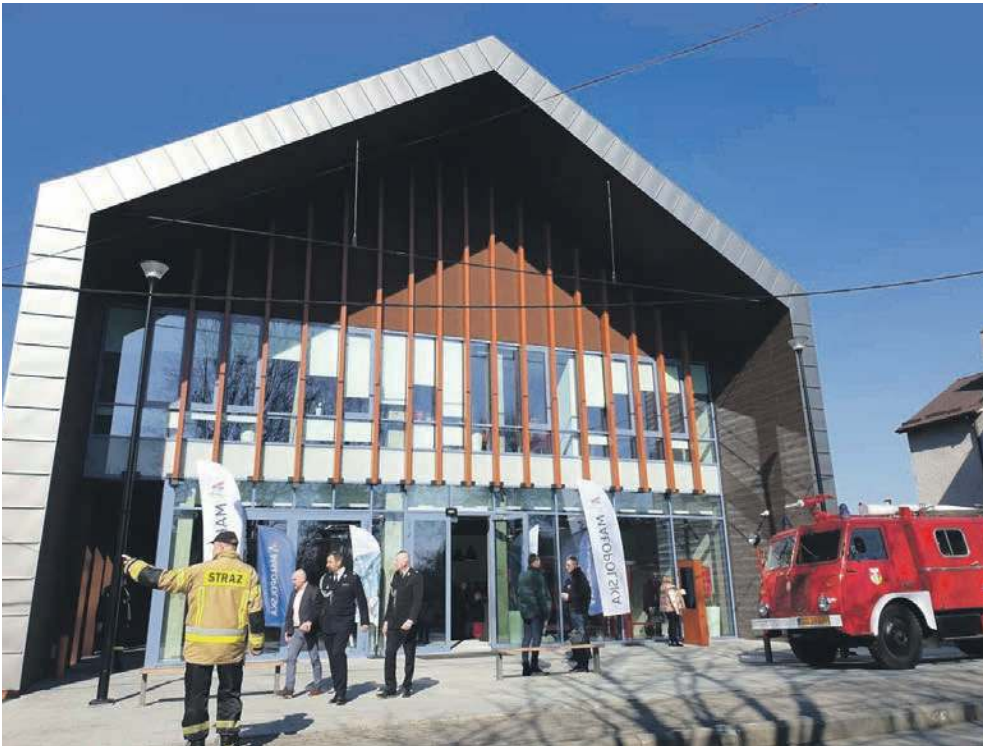
Budynek muzeum widoczny od strony głównego wejścia
