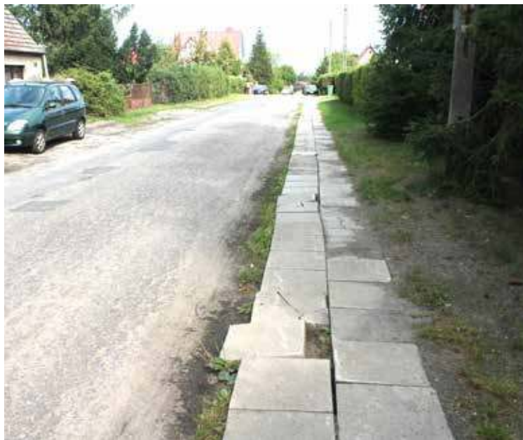
Niektóre płyty chodnikowe ulegają degradacji i zaczynają nieestetycznie wystawać poza krawędź chodnika (zdjęcie z sierpnia 2021)
