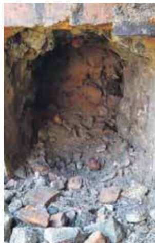
Widoczne odrzwia i zawiasy świadczą o tym, że były tutaj drzwi. Dokąd prowadziło wejście?
