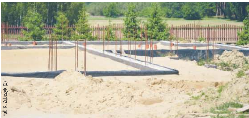
Tak wygląda aktualnie plac budowy.
